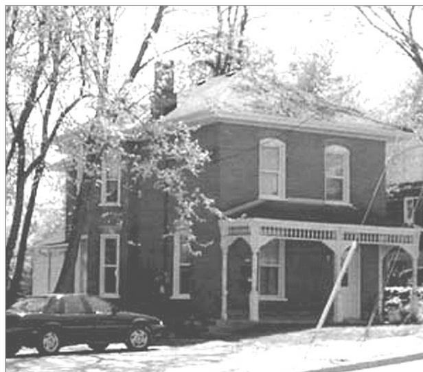
Slika 2: Vključevanje skupnosti v prenavljanje starejših stavb (Homegrown homes – Peterborough City, Kanada; vir: internet 1)
